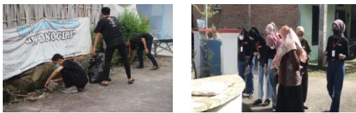
Gambar 2. Pengecekan dan Pembersihan Saluran Air (sumber : dokumen pribadi)
